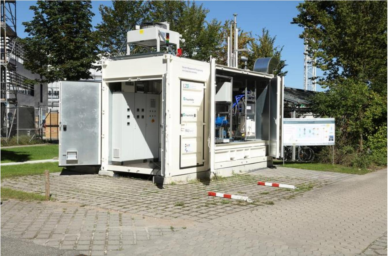
Der Container umfasst zwei getrennte Abteile, eines für die effiziente Anbindung ans elektrische Netz und die Steuerungstechnik (vorne), das andere für den verfahrenstechnischen Aufbau.
