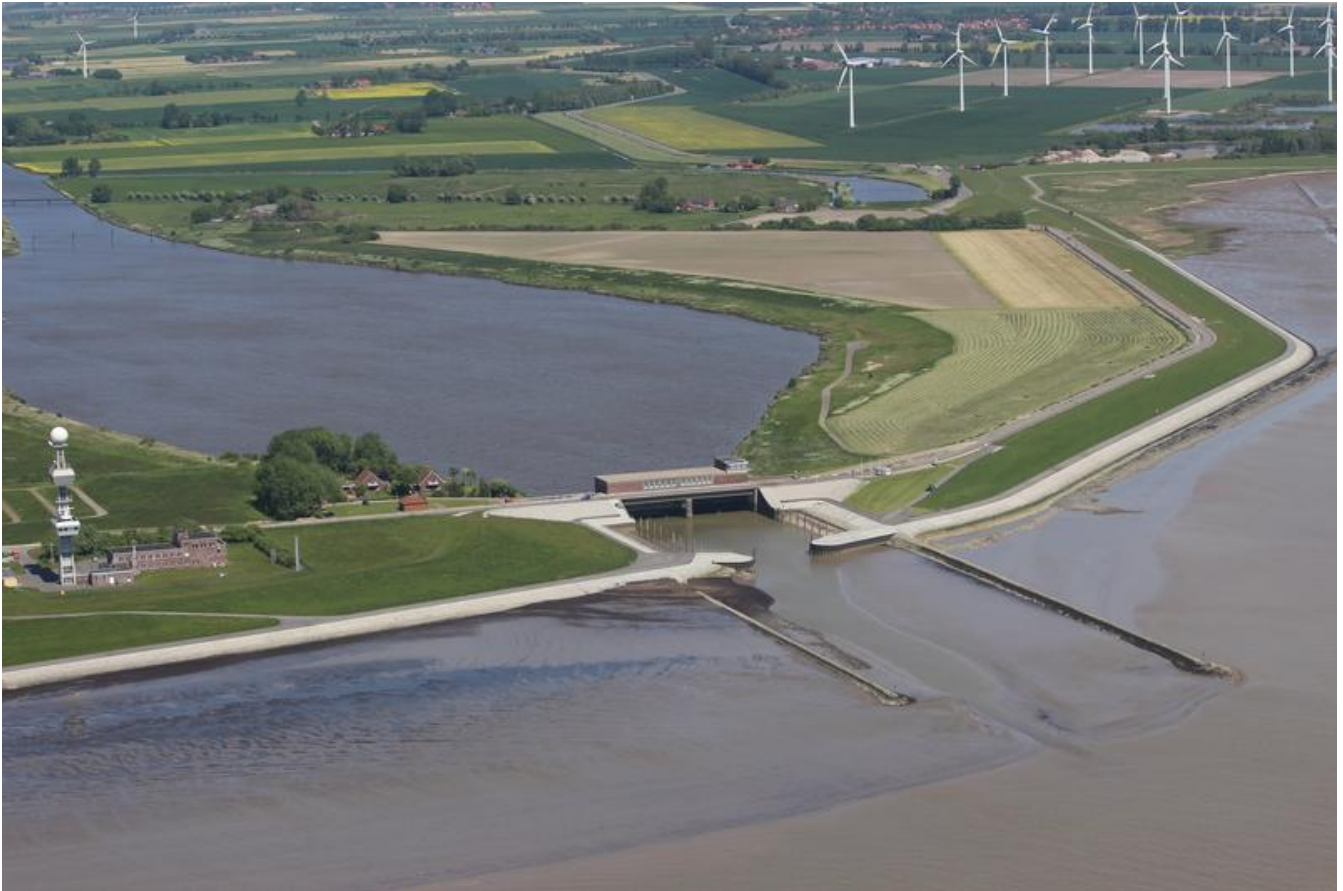
Durch den Anstieg des Meeresspiegels wäre der Abfluss des Wassers über die Siele laut Modellergebnissen Ende des Jahrhunderts nicht mehr möglich. Foto: I.EVE
