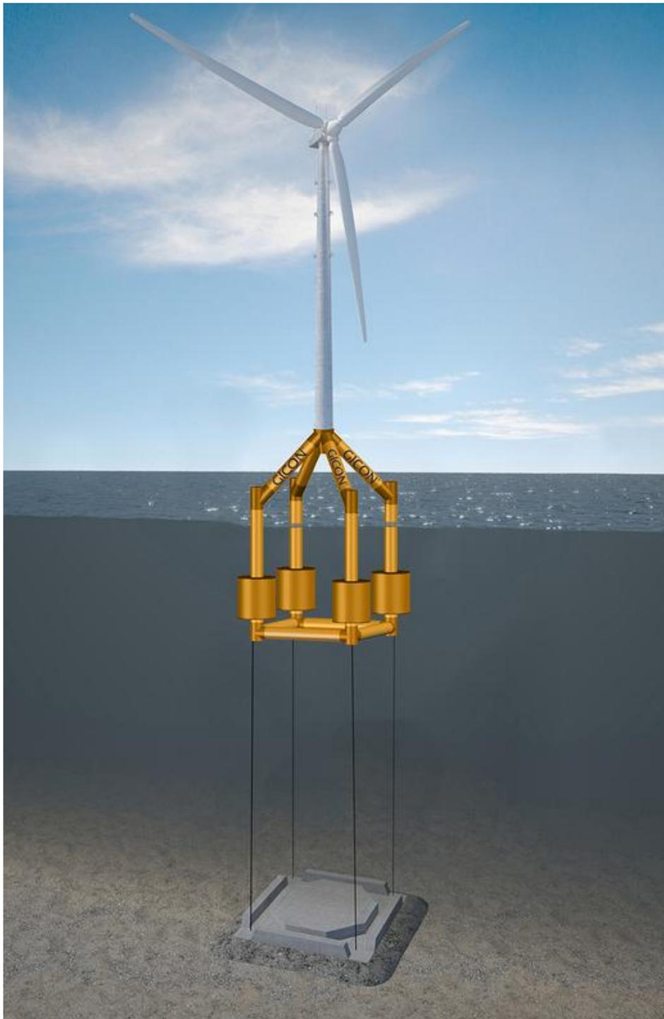
Visualisierung der Schwimmplattform GICON<sup>®</sup>-SOF<sub>3</sub>. Das Schwimmende Offshore-Fundament wird mit Seilen verspannt. Die Seile verbinden das schwimmende Fundament mit dem auf dem Meeresboden liegenden Schwergewichtsanker.
