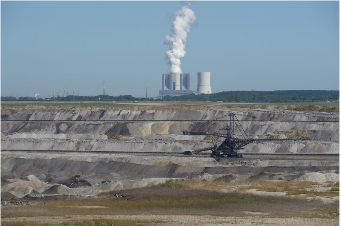
Das Braunkohlekraftwerk Böhlen Foto: Colourbox
