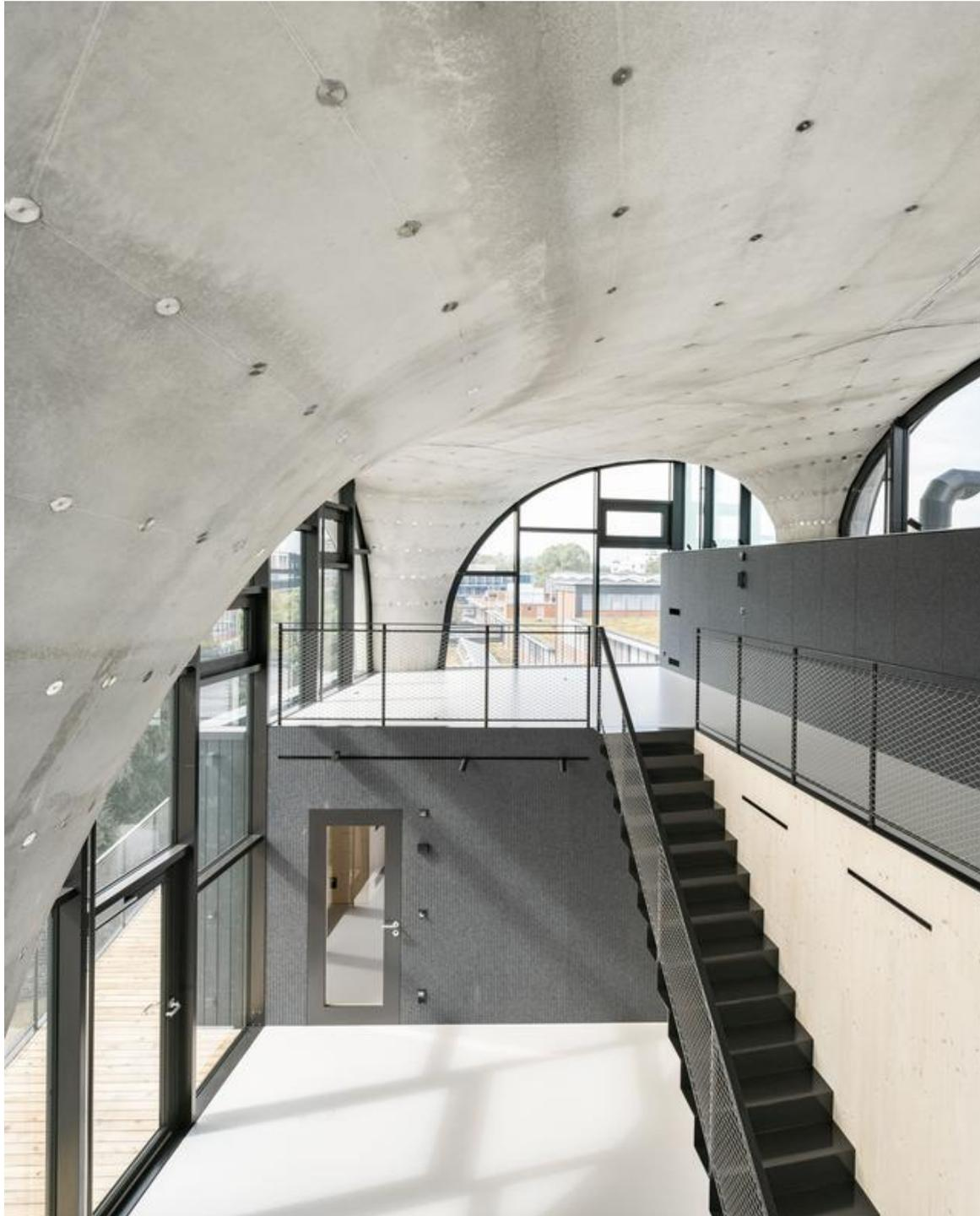
Das doppelt gekrümmte Dach besteht aus zwei Betonschichten, die durch ein Gitter aus Betonrippen und Stahllanker verbunden sind. Gebaut wurde es mit Hilfe einer flexiblen Schalung aus einem gespannten Seilnetz und einer Membran.
