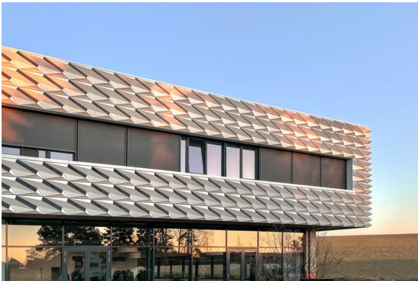
Die Fassade des Firmengebäudes von Aluform in Bad Rappenau-Bonfeld produziert dank Photovoltaik 10.000 Kilowattstunden Strom pro Jahr Tim Friedrich Aluform
