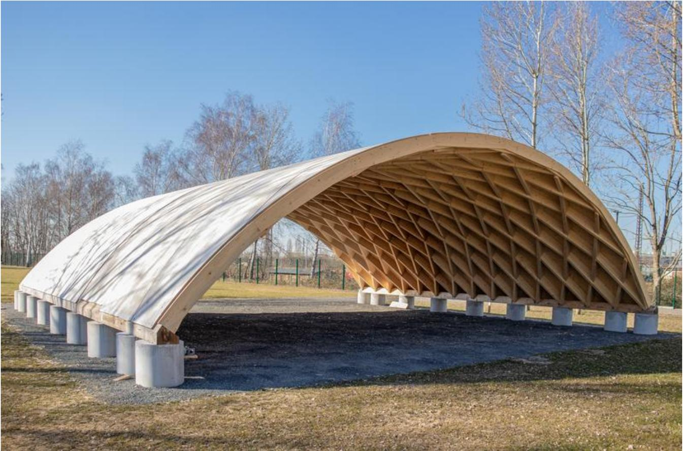
Die Forschungsgruppe FLEX will der Zollinger-Bauweise zu einer Renaissance verhelfen. Auf der Denkmal-Messe zeigen sie zwei Elemente eines digital geplanten und konstruktiv weiterentwickelten Zollingerdachs.
