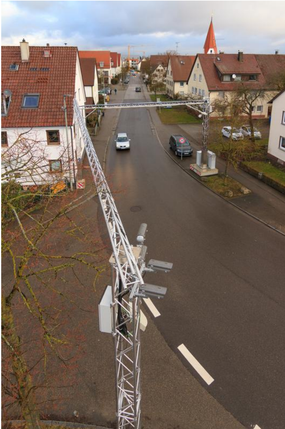
Infrastruktursensorik der Pilotanlage an einer Kreuzung im Ulmer Stadtteil Lehr Foto: Martin Herrmann
