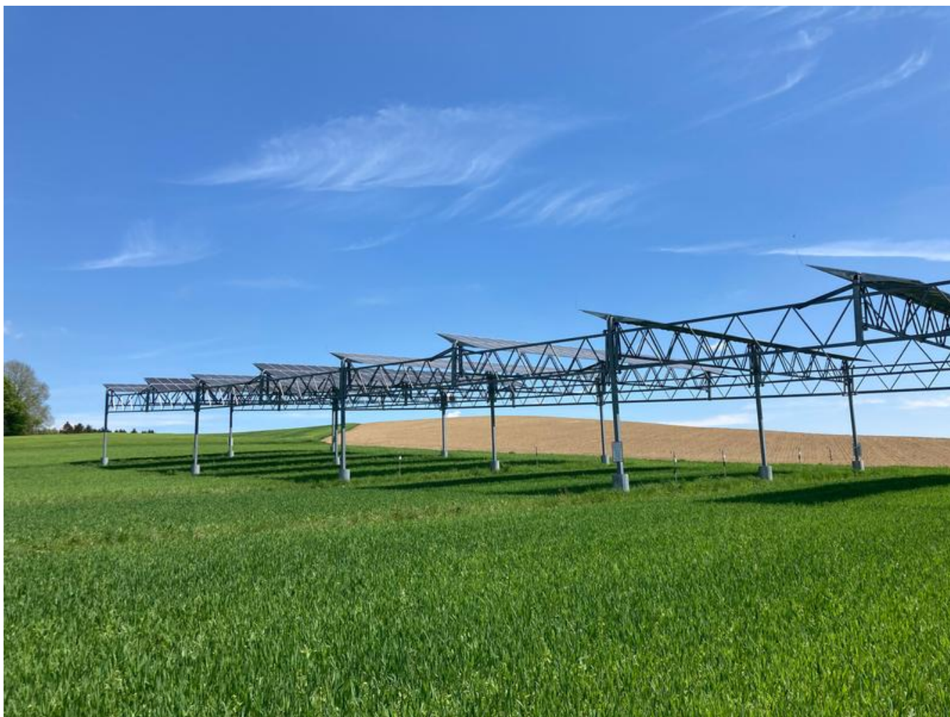
Bei Dürre sogar ertragssteigernd: Hoch aufgeständerte Agri-Photovoltaikanlagen schützen durch Beschattung. Universität Hohenheim / Andreas Schweiger
