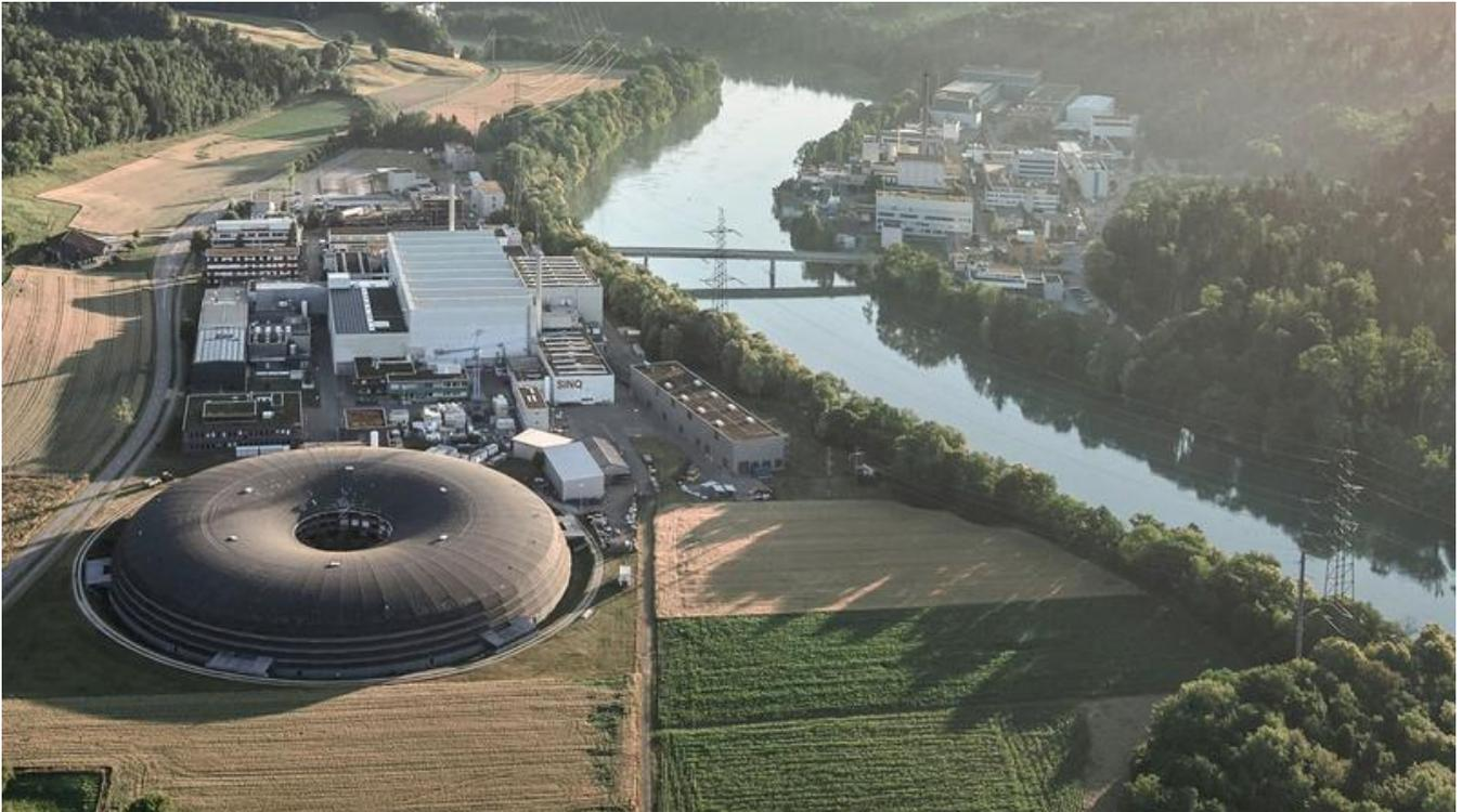
Das wohl markanteste Gebäude des PSI: Die SLS ist kreisrund, entsprechend dem Elektronenspeicherring von 288 Metern Umfang, der darin verläuft.
