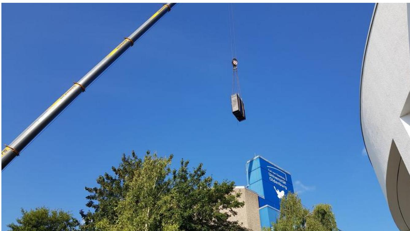
Die Universität Oldenburg hat im vergangenen Jahr neue, wassergekühlte Hochleistungsrechner erhalten, die mit einem Kran angeliefert werden mussten. Die Abwärme der Server wird nun in das Wärmenetz der Universität eingespeist.
