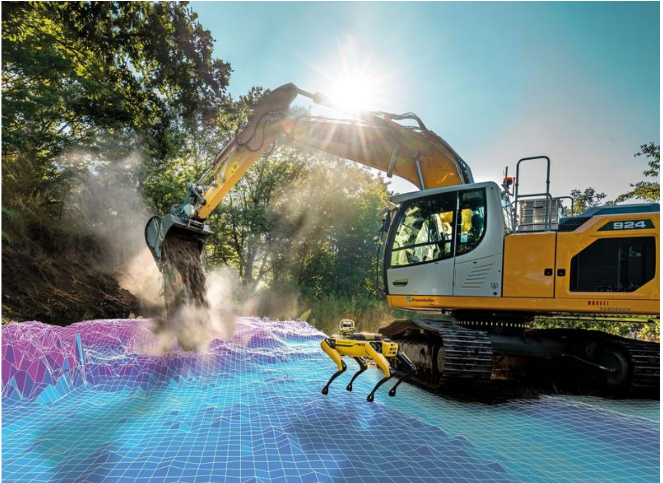
Autonomer Bagger in Aktion. Im Vordergrund der optional zur Geländeerkundung einsetzbare Roboterhund Spot; als Untergrund ist das von den Sensoren Fraunhofer IOSB / M. Zentsch [M.]
