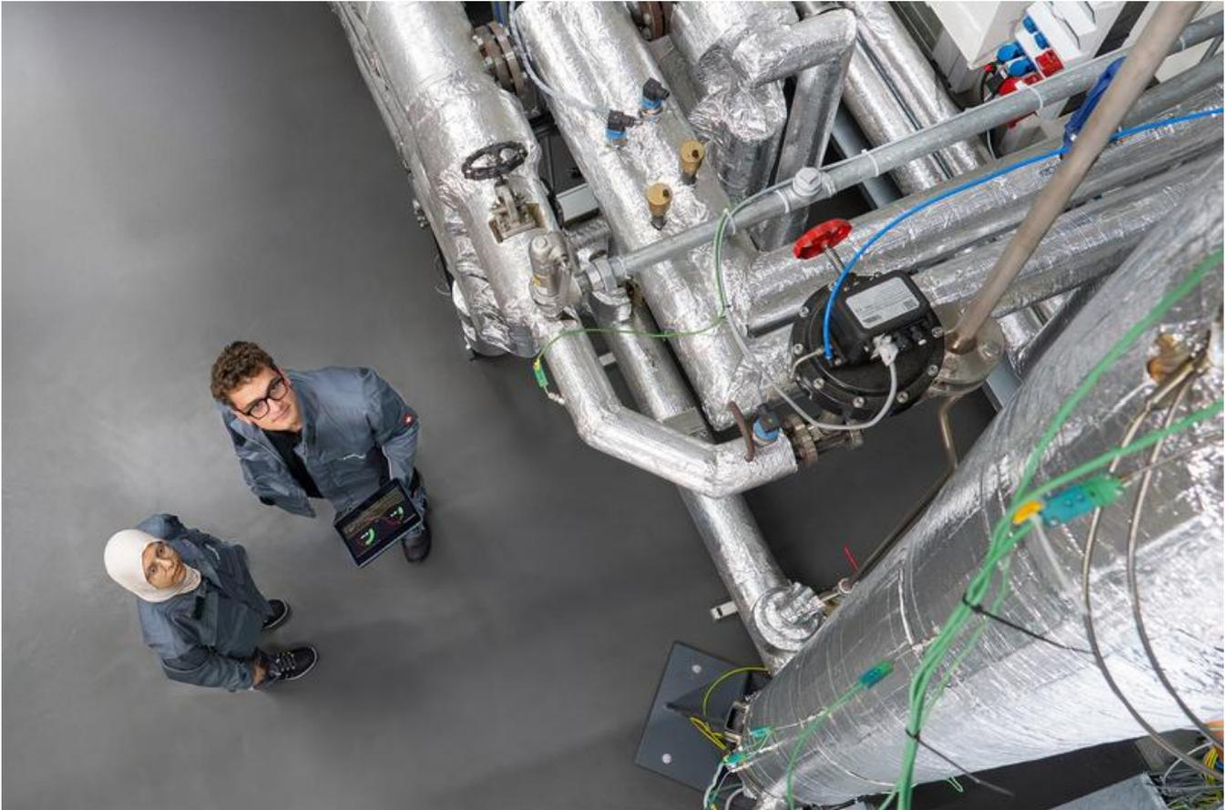
Forschende von Fraunhofer UMSICHT mit Latentwärmespeicher auf Basis einer Metalllegierung. Eine Demonstrationsanlage dieses Speicherprinzips wird bei der Bitburger Brauerei aufgebaut.
