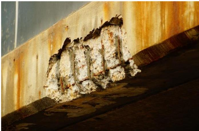
Betonabplatzung an einer Brücke; © AdobeStock / Kay GebauerWirestock
