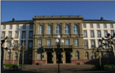
Das Hauptgebäude der Justus-Liebig-Universität Gießen, in dessen Aula die Tagung stattfindet.
