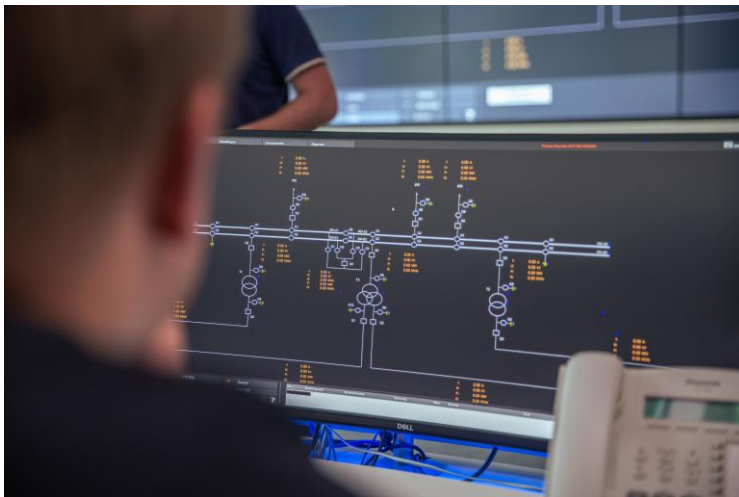
Leittechniklabor am Fraunhofer IOSB-AST. Bild: Fraunhofer IOSB-AST
