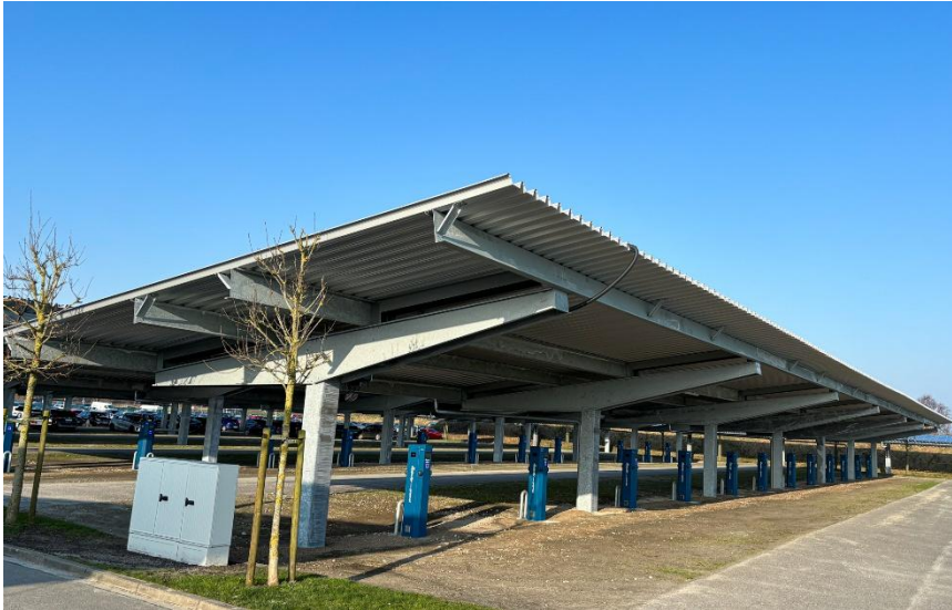
Bildunterschrift: Ist keine Fähre im Hafen, können Gäste ihre Elektrofahrzeuge über die eigene PV-Anlage der Reederei laden (Foto: Reederei Norden-Frisia).
