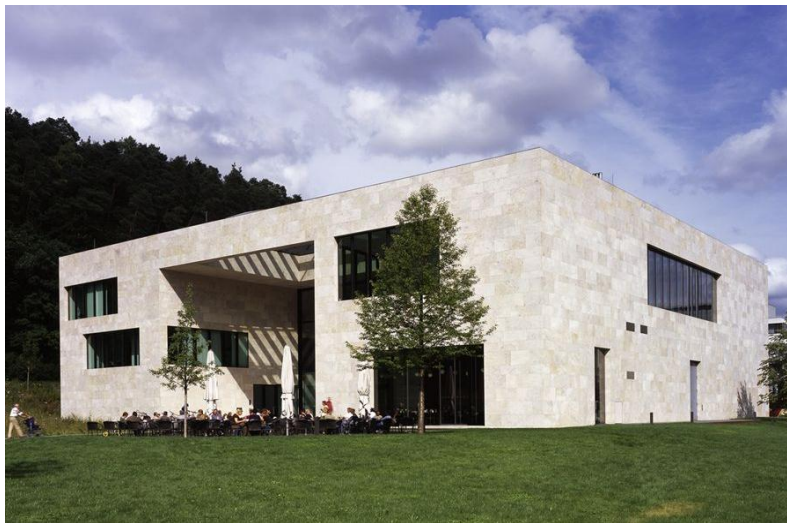
Energieeffizienz konzipiert: das Gebäude des „Museums Ritter“ in Waldenbuch. KIT-Forscher haben das Energie-Monitoring und die Betriebsoptimierung übernommen. (Foto: Museum Ritter Waldenbuch)
