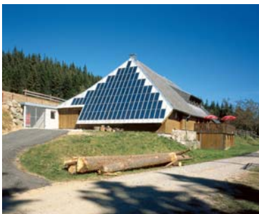
Solargenerator auf der Rappenecker Hütte ©Fraunhofer ISE/Foto: Guido Kirsch
