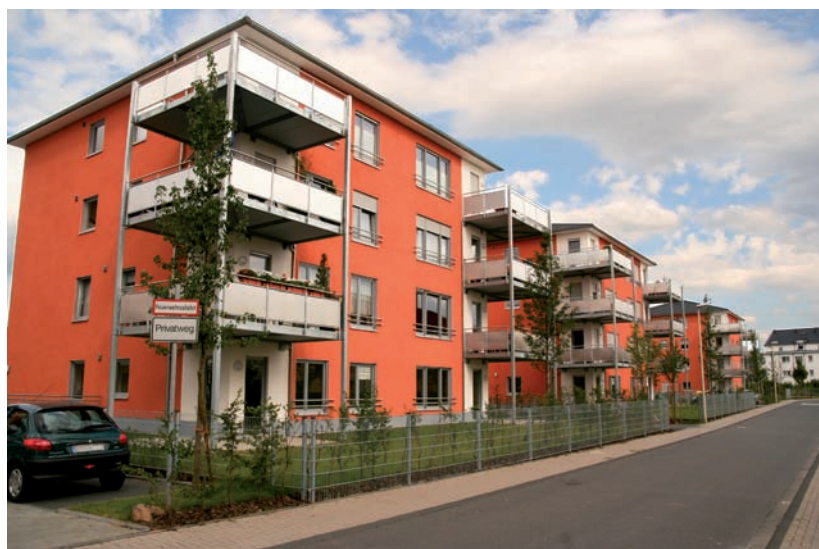
Neue Mehrfamilienhäuser in Bonn-Beuel
