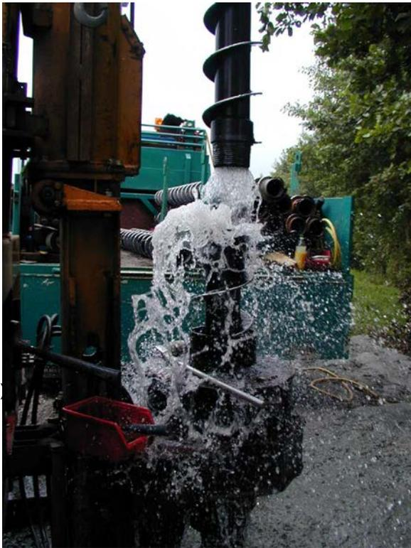
Bild 1: Grundwasserbohrung zur Untersuchung der Salz-/Süßwassergrenze
