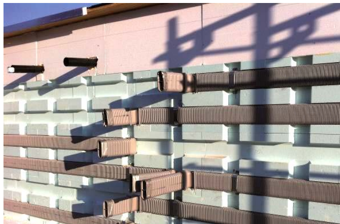
Multifunktionales Fassadenelement mit Wärmedämmplatten aus expandiertem Polystyrol (EPS) und integrierter Kanalführung aus Kunststoffrohren. ©Fraunhofer ISE
