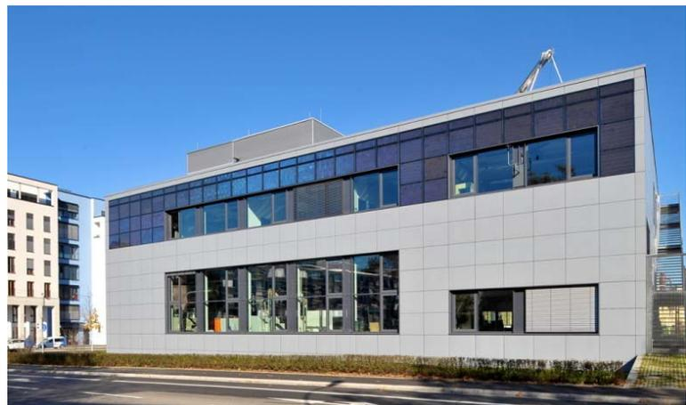
Das Fraunhofer-Institut für Solare Energiesysteme ISE hat die Außenfassade eines seiner Laborgebäude mit 70 Photovoltaik-Modulen aus eigener Entwicklung und Pilotproduktion ausgerüstet. ©Fraunhofer ISE
