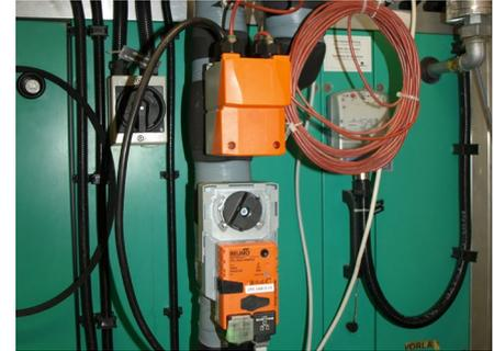
Das Ventil reguliert den Wasserdurchsatz des Wärmetauschers der Klimaanlage, damit dieser am optimalen Punkt arbeitet.
