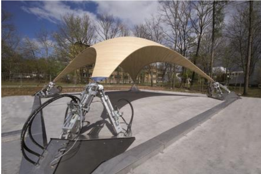
Adaptives Tragwerk in Form einer Holschale: Die Stuttgart SmartShell. (Foto: Bosch Rexroth)
