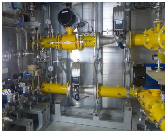
Anlage, die Wasserstoff in das bestehende Gasnetz einspeist, unter Einhaltung der Gasnetz-Kennwerte/Grenzwerte. © Fraunhofer ISE
