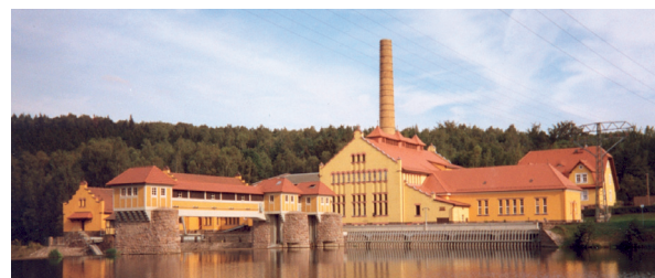
Wasserkraftwerk Mittweida, Foto: Förderverein WKW
