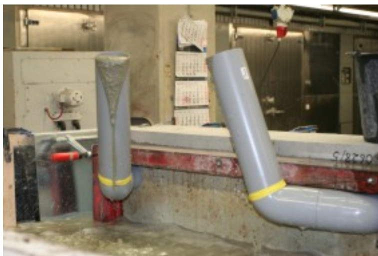
Abgeschlossen: Beton tritt aus den Entlüftungsrohren - ein Zeichen dafür, dass die Verschalung fertig gefüllt ist.
