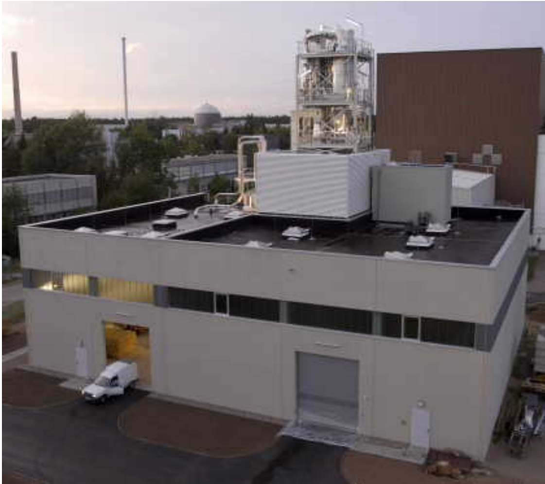
Im Forschungszentrum Karlsruhe entsteht zur Zeit eine Anlage zur Demonstration des biolig-Prozesses, deren erste Stufe - die Schnellpyrolyse - im Juni 2007 eingeweiht wurde. Foto: Forschungszentrum Karlsruhe
