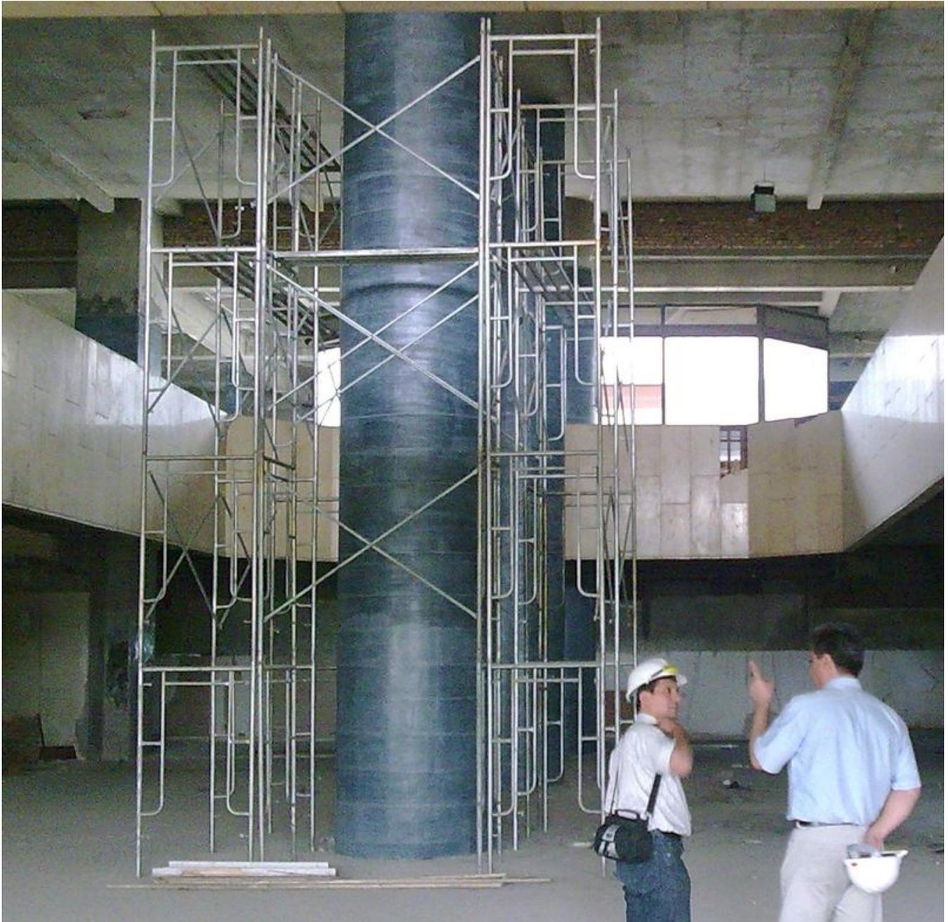
Blick in die Halle des Teheraner Hotels Azadi: Um das 28 Stockwerke hohe Hotel erdbebensicher zu machen, wurden die zehn Meter hohen Stützen aus Stahlbeton mit CFK-Gewebe umwickelt.
