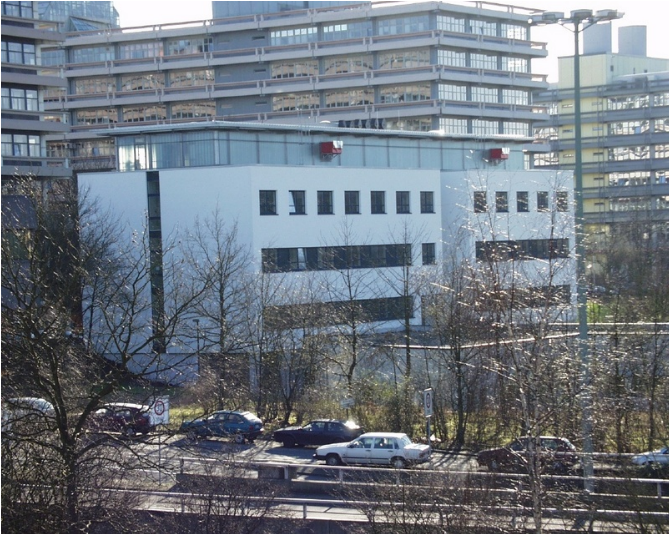
... das "Zentrum Klinische Forschung" (ZKF) mit modernster Gebäudetechnik
