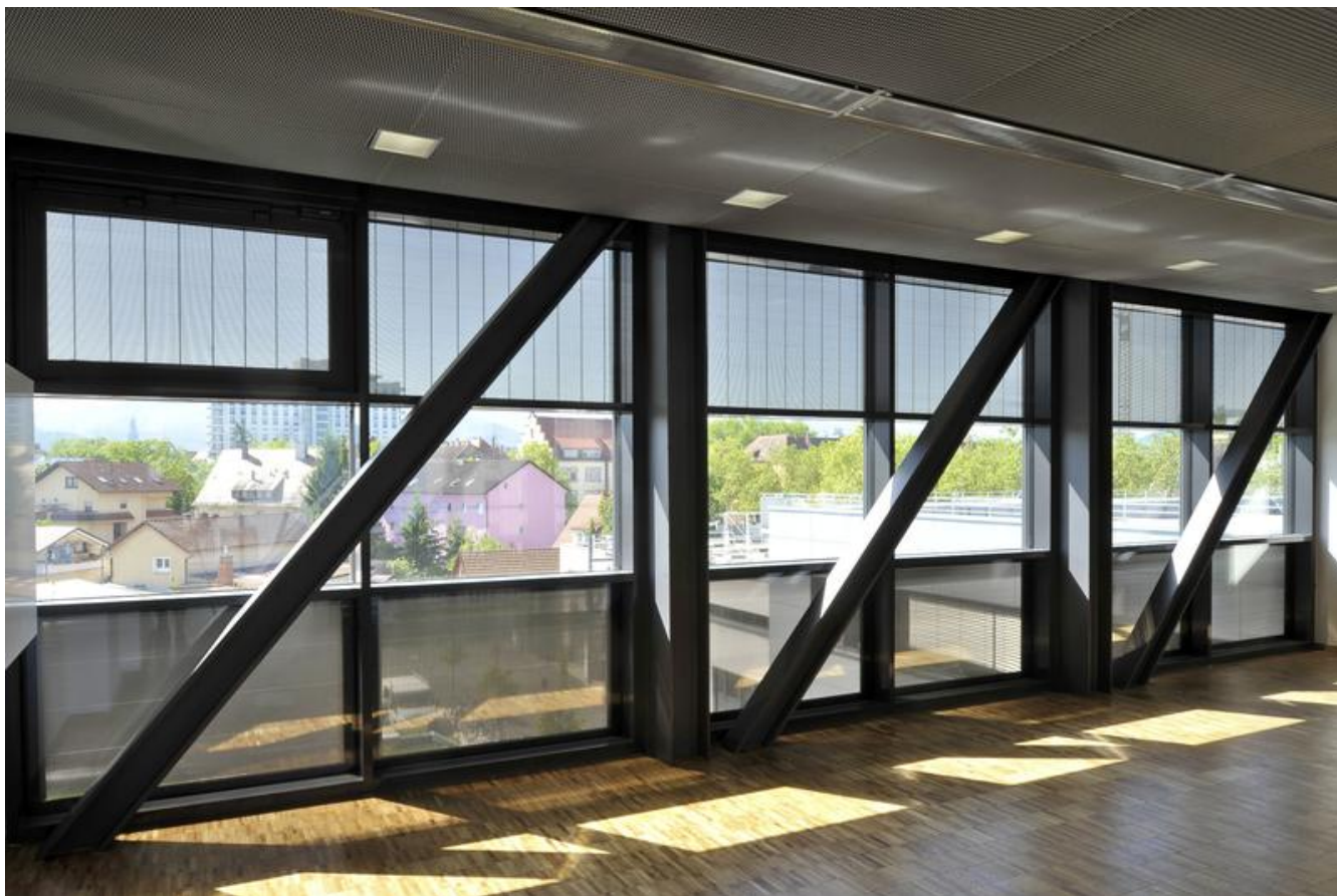
Laborneubau Fraunhofer ISE: Seminarraum mit bauwerksintegrierter Photovoltaik (BIPV) – teiltransparente PV-Module mit winkelselektiver Transmission (PV-Shade®). ©Fraunhofer ISE
