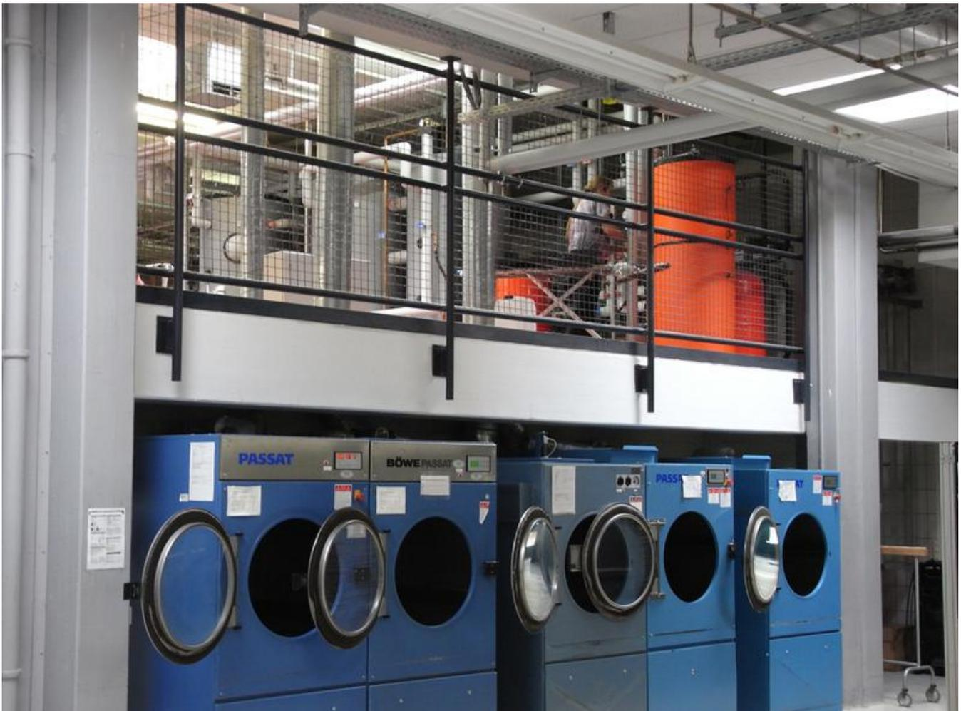
Das Fraunhofer ISE entwickelt ein Branchenkonzept für die Nutzung von Solarwärme in Wäschereien. Solarthermische Anlagen werden in die Betriebe integriert, um einen Teil des Wärmebedarfs einzelner Prozesse zu decken. Oben im Foto zu sehen sind die Speicher einer Solaranlage, die Wärme für Kessel-Zusatzwasser, Kessel-Speisewasser und Waschmaschinen bereitstellt. @Fraunhofer ISE
