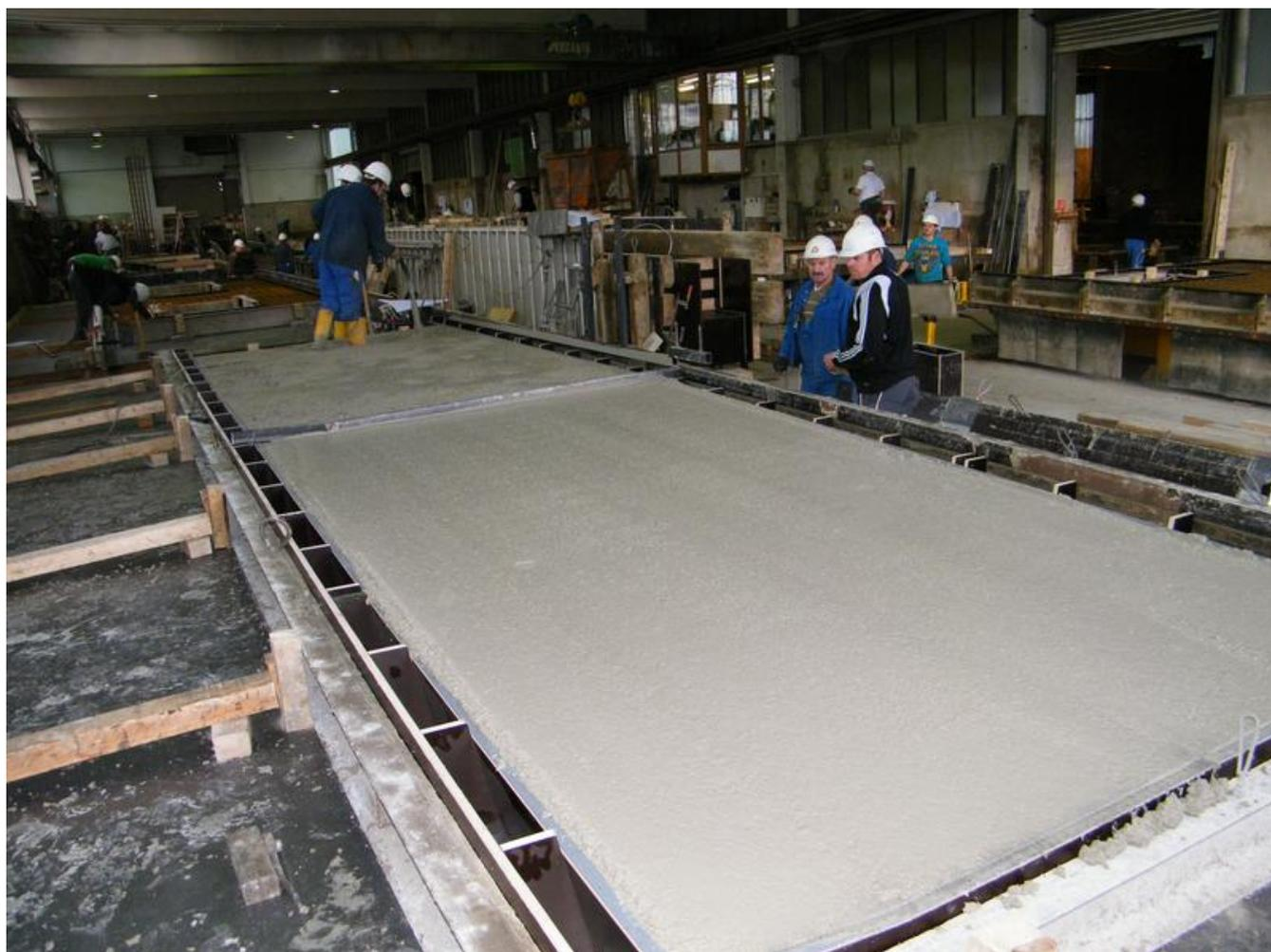
Herstellung eines Brückenbauteils aus Ultrahochleistungsbeton (Quelle: Zoz GmbH)
