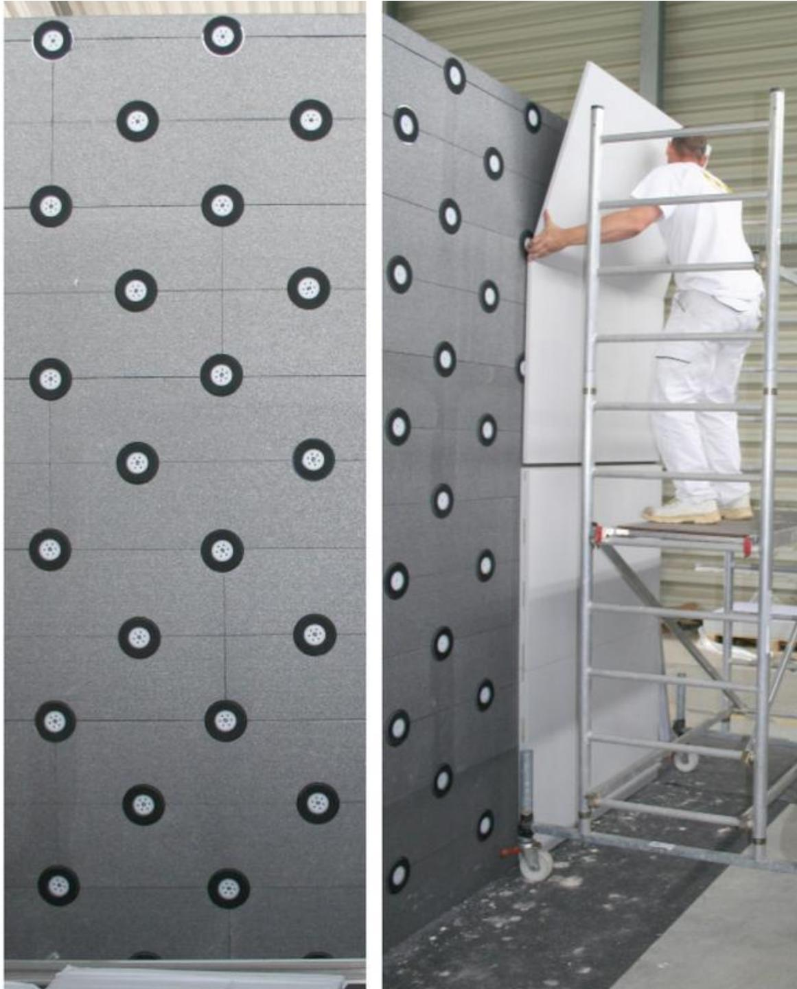
Kletten statt kleben: Das Fassadensystem facade4zeroWaste lässt sich einfach montieren und im Sinne der Nachhaltigkeit sortenrein trennen und wiederverwenden.
