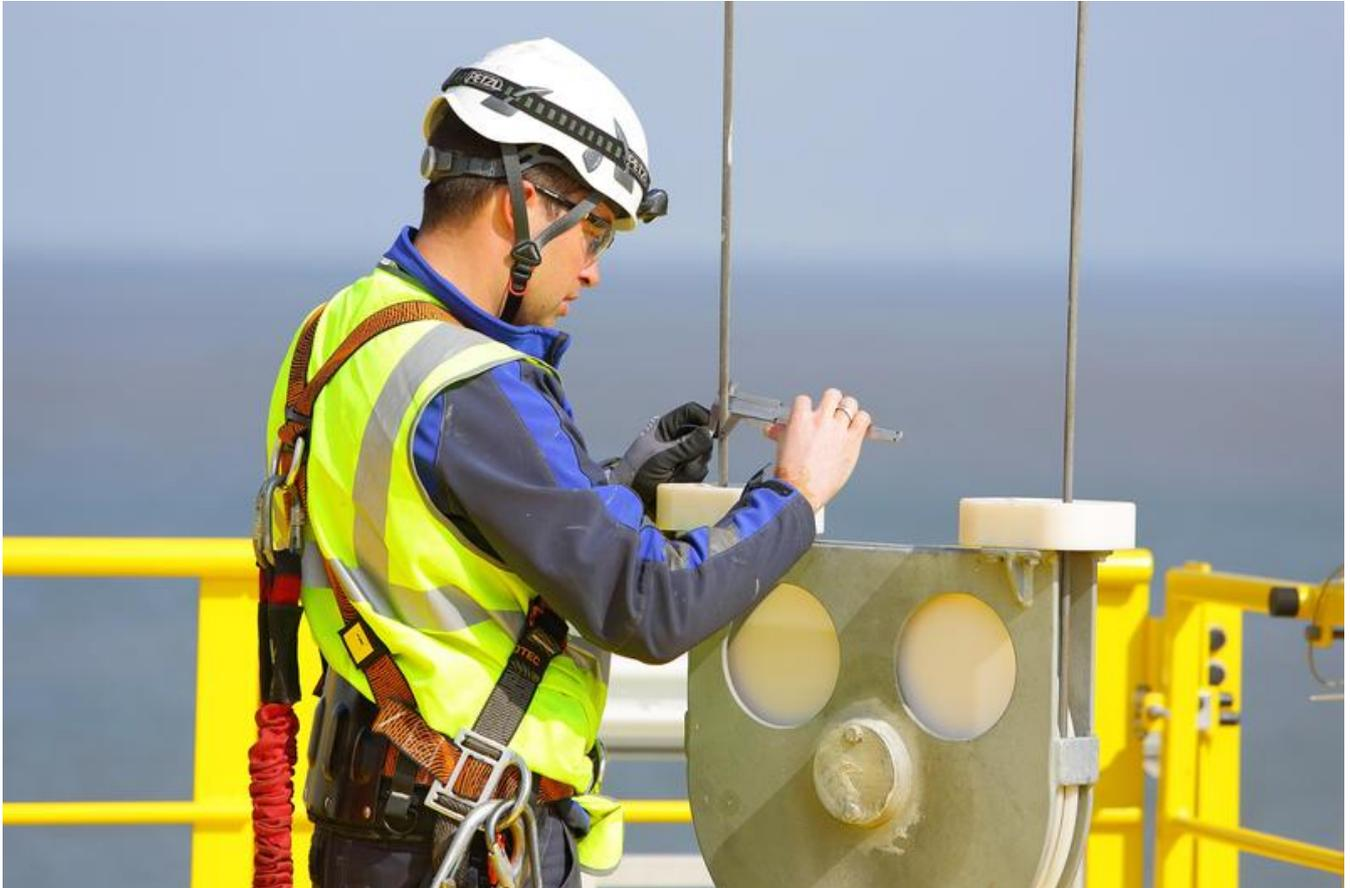
Hoch oben auf einer Offshore-Windenergieanlage: Ein gut gesicherter Techniker prüft den Durchmesser eines Stahlseils.
