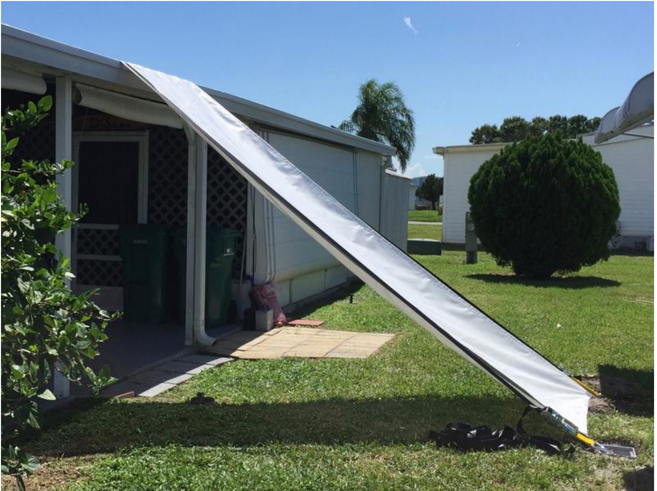
Die an der TU Dresden entwickelten Windschutzplanen greifen die Windkraft auf, die das Dach abzudecken droht, und leiten sie nach unten um. © Stefan Siegmund
