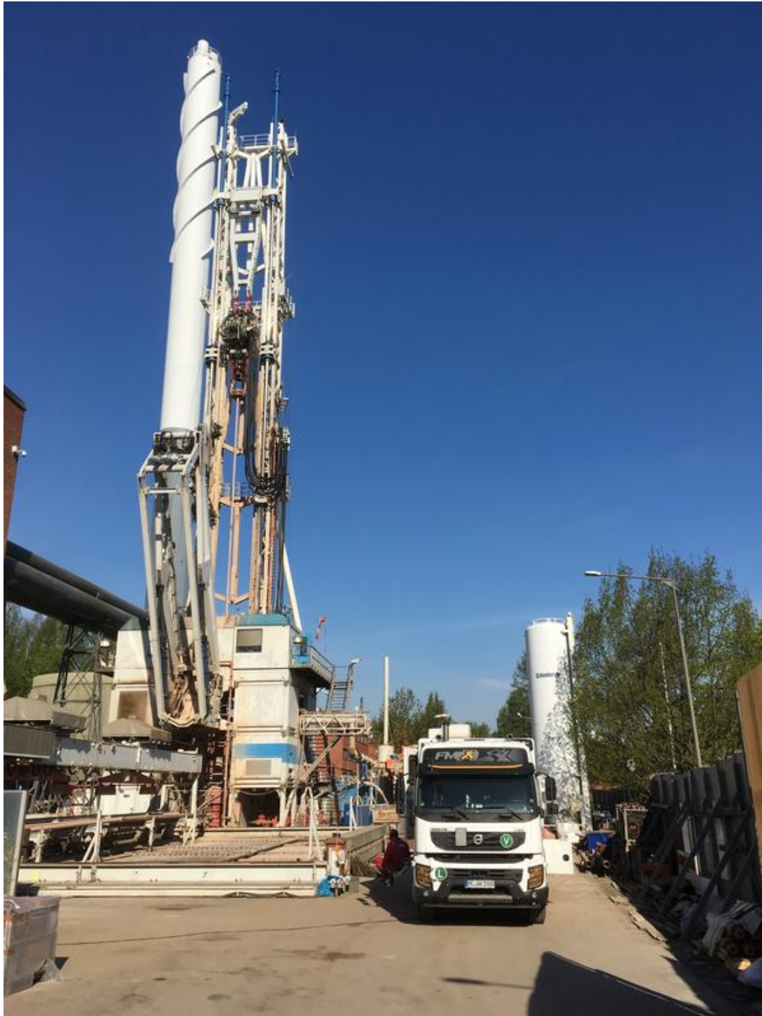
Bohranlage des Geothermieprojektes in Helsinki, Finnland. Das Projekt hat das Ziel, den Universitätscampus mit Wärme aus mehr als 6 Kilometern Tiefe zu versorgen G. Dresen
