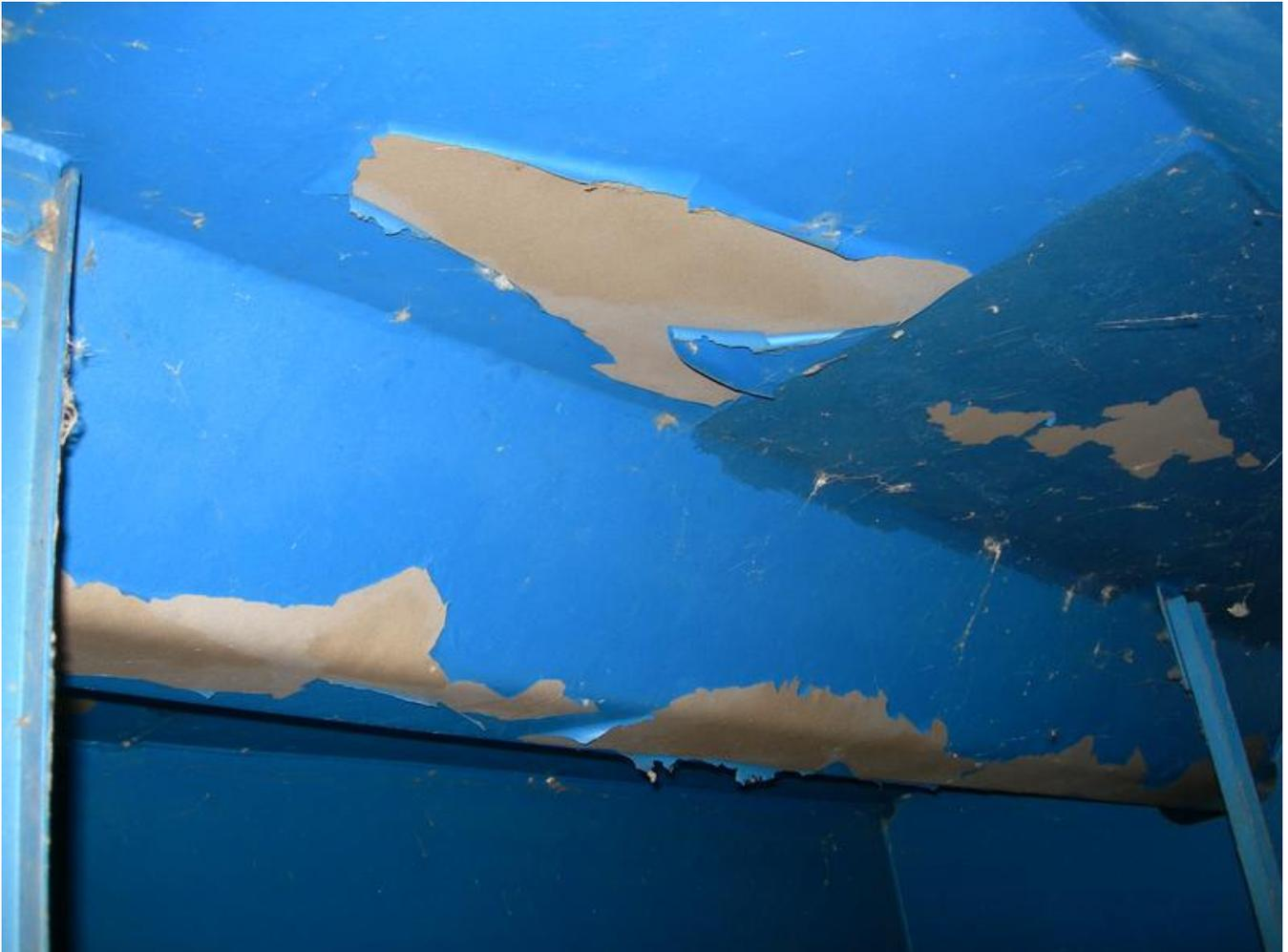
Schadensfall durch Enthftung der blauen Polyurethandeckbeschichtung an einer Brückenkonstruktion
