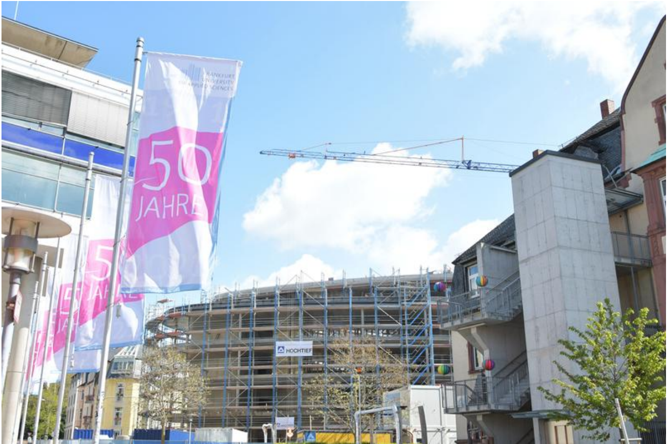
Richtfest für das neue Mehrzweck- und Seminargebäude auf dem Campus der Frankfurt UAS. Quelle: Frankfurt UAS/B. Bieber
