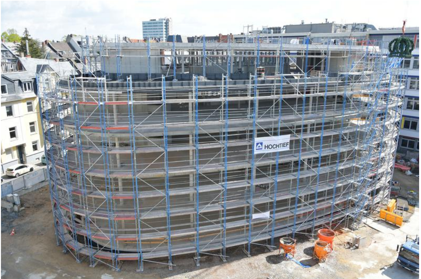
Richtkranz wird am neuen Gebäude 10 angebracht. Quelle: Frankfurt UAS/B. Bieber
