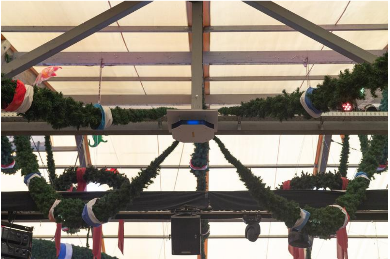
Die UVC-Technologie bleibt im Festzelt unauffällig: Unter der Decke wurden die UVC-Geräte angebracht. K. Jungblut Festhalle Schottenhamel
