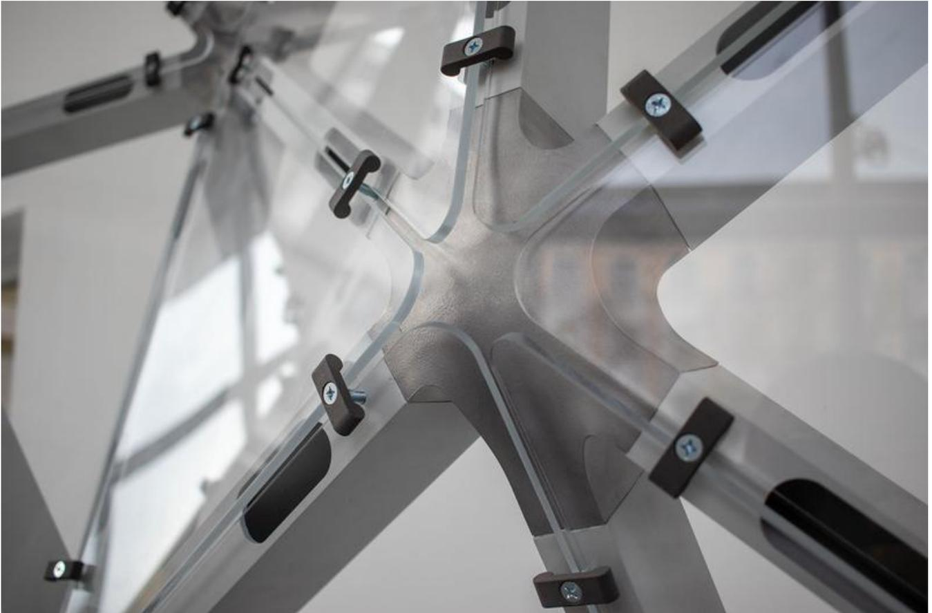
Mittels neu entwickeltem Verfahren hergestellter Stahlknoten
