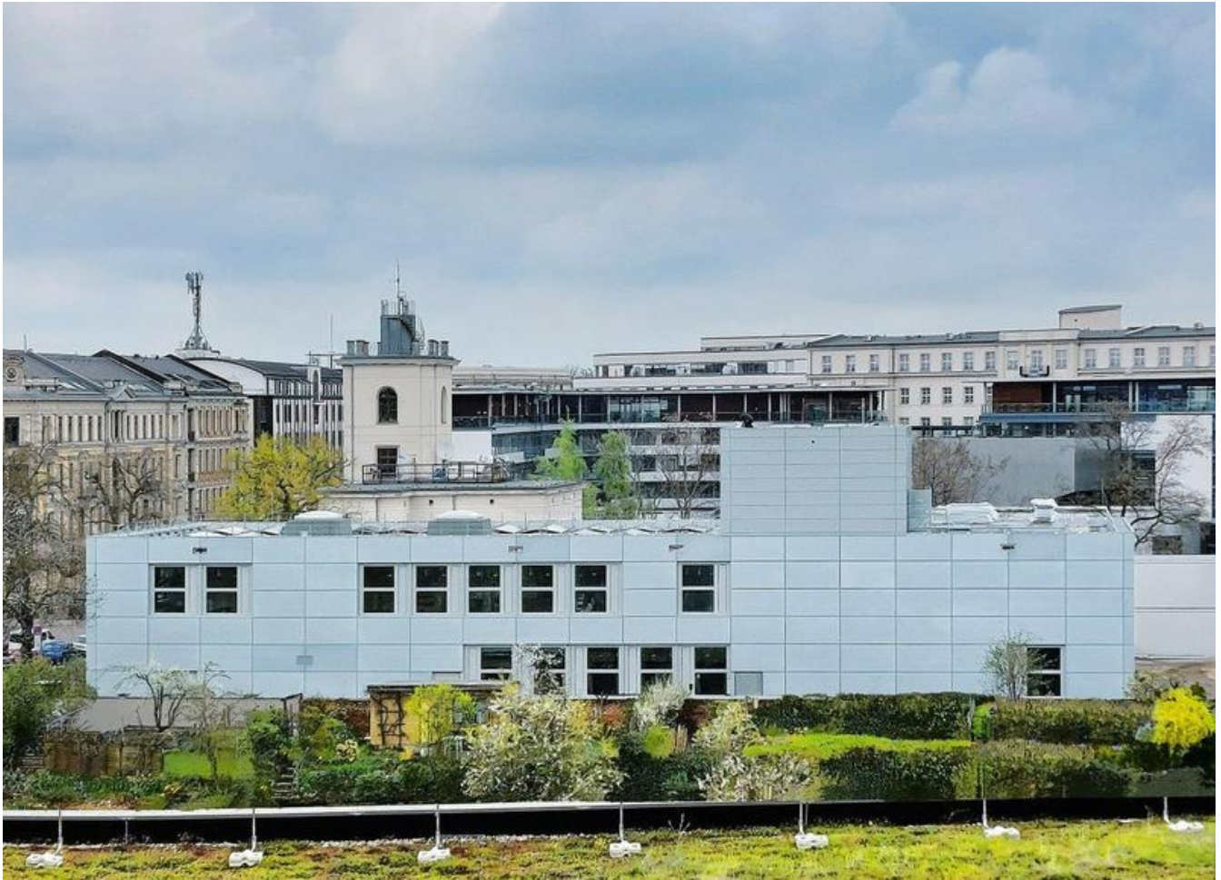
Das neue Forschungsgebäude des Instituts für Meteorologie der Universität Leipzig. Cornelia Ködderitzsch Staatsbetrieb Sächsisches Immobilien- und Baumanagement (SIB)
