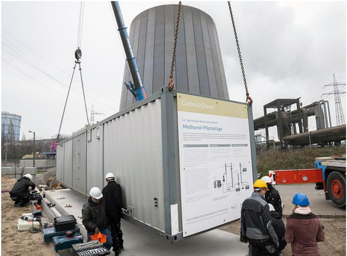
Aufbau der Methanolanlage im Carbon2Chem®-Technikum bei thyssenkrupp Steel Europe in Duisburg.
