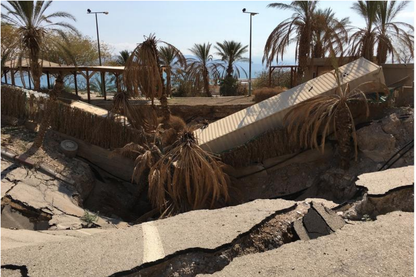
Der Eingangsbereich von Mineral Beach am Toten Meer. Der Einbruchskrater entstand über Nacht, wodurch glücklicherweise niemand zu Schaden kam. UFZ
